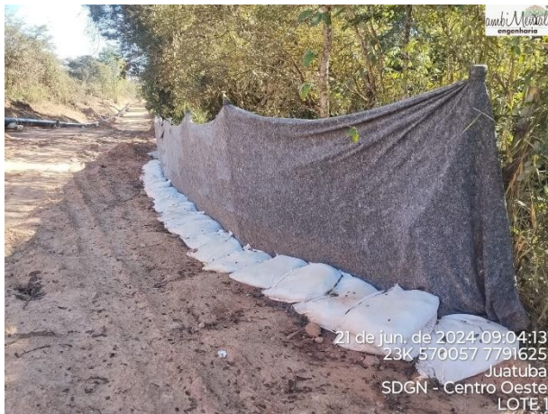
Figura 4 – Utilização de manta bidim para contenção. Data: 21/06/2024. Coordenadas Geográficas UTM 23 k longitude 570057 latitude 7791625.
