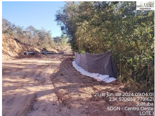
Figura 5 – Utilização de manta bidim para contenção (panorâmica). Data: 21/06/2024. Coordenadas Geográficas UTM 23 k longitude 570059 latitude 7791621.
