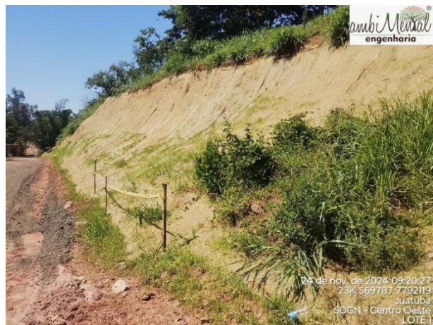
Figura 11 - Biomanta aplicada. Data: 24/11/2024. Coordenadas Geográficas UTM 23 k longitude 569787 latitude 7792119.
