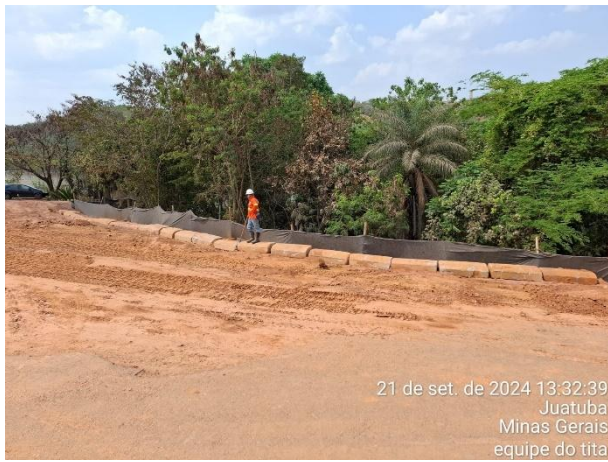
Figura 8 – Sacaria, madeiras e manta bidim. Data: 21/09/2024. Coordenadas Geográficas UTM 23 k longitude 569754 latitude 7792143.
