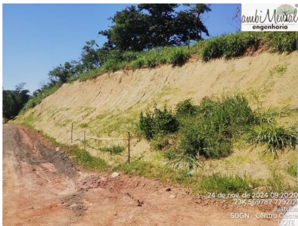
Figura 10 - Biomanta aplicada. Data: 24/11/2024. Coordenadas Geográficas UTM 23 k longitude 569787 latitude 7792121.
