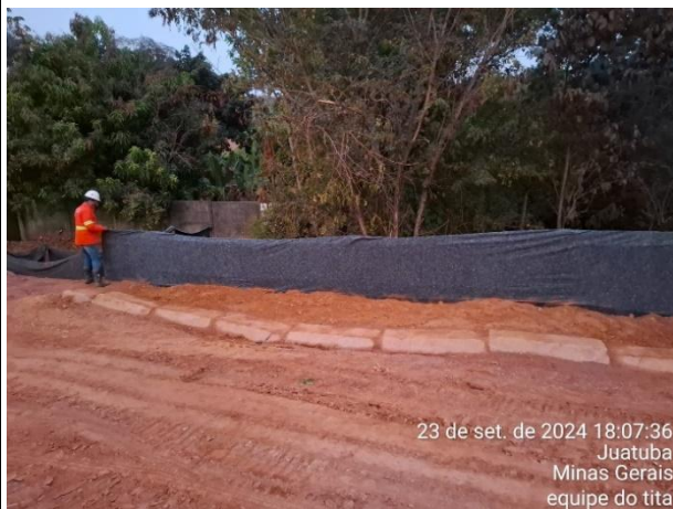
Figura 6 – Contenção com bidim (panorâmica). Data: 23/09/2024. Coordenadas Geográficas UTM 23 k longitude 569754 latitude 7792143.
